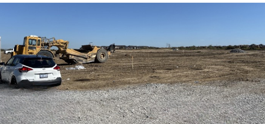
Rough Grading Subdivision
